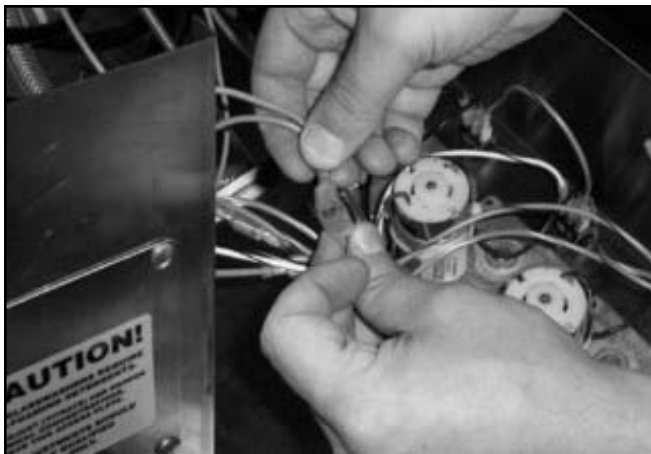
Unhooking motor power wire
